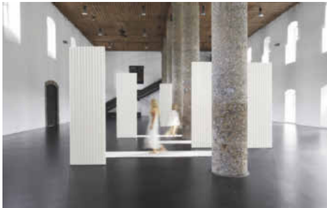
Wellenförmige Absorber aus rezykliertem Aluminium und Merinowolle verbessern nicht nur die Raumakustik, sondern setzen besondere gestalterische Akzente.
